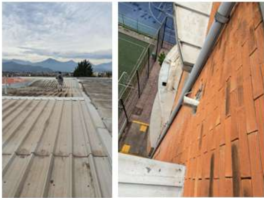
Destape y cambio de tubos de desagüe.
