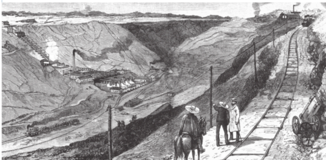
Prior, M. (1889). Trabajos en salitreras chilenas . Santiago, Chile: Biblioteca Nacional de Chile.
